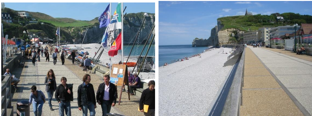
LA DIGUE REAMENAGEE EN PROMENADE POUR AMELIORER LE CADRE DU SITE – AURH 2011 – AURH 2007
