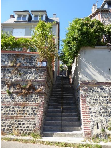
ESCALIER QUI GRIMPE LA COSTIERE – AURH 2022
