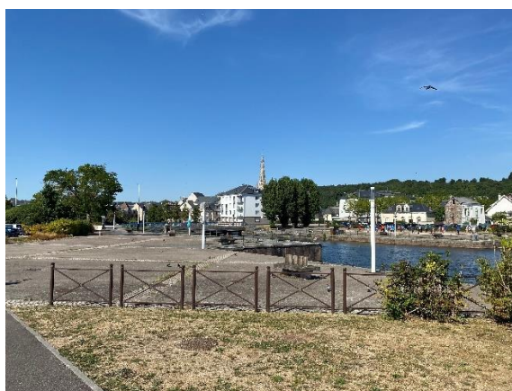
EMBOUCHURE DE LA LEZARDE CANALISEE QUI SE JETTE DANS LE CANAL DE TANCARVILLE A HARFLEUR – AURH 2022
