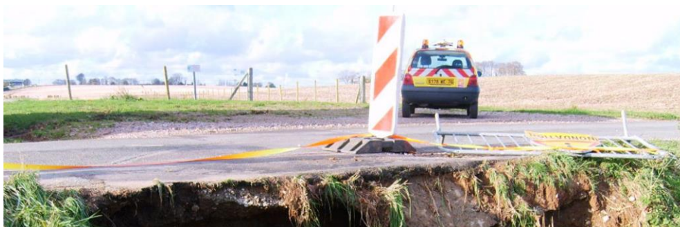
OUVERTURE D'UNE MARNIERE ©LE HAVRE SEINE METROPOLE
